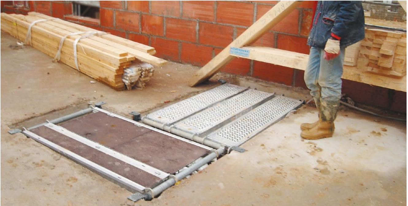
Mise en œuvre d'une protection de trémie, par un plancher manufacturé provisoire autoportant et anti-dérapant sur toute la surface de la trémie, équipé :
