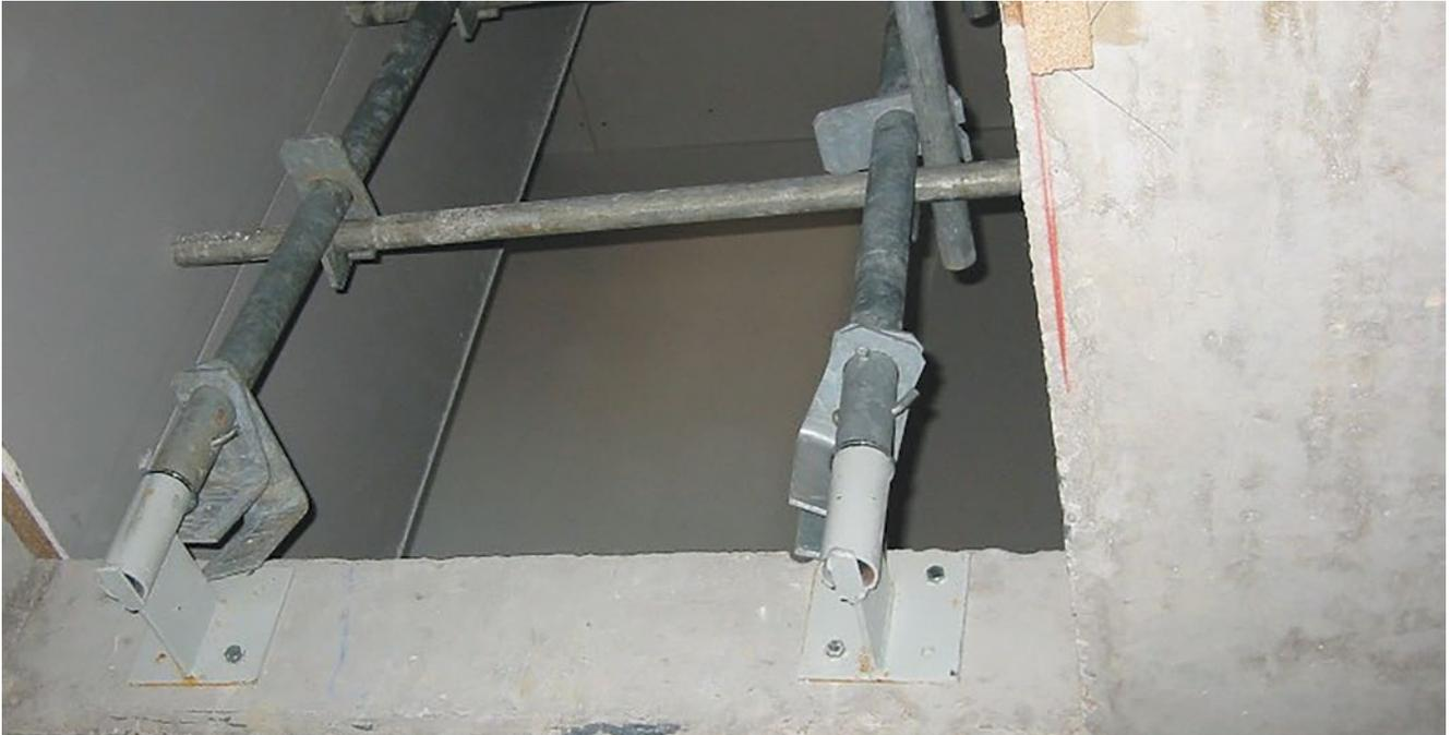
Mise en œuvre de platines d'ancrage en nez de dalle en acier galvanisé fixées à l'anglaise / à la française, en fonction des interventions des autres corps d'état sur les nez de dalles (fixations des garde-corps, finitions, etc...). Ces platines serviront de support de potelets et de lisses afin de former un garde-corps temporaire, de classe A, le tout conforme à la norme NF EN 13374.
